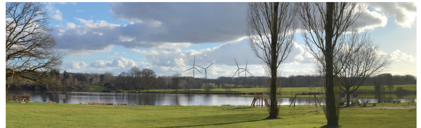
Photographie 169 : Un panneau d'information localisé à proximité de l'étang de la Chaume permettra de mieux informer les visiteurs sur le parc éolien de Lif.
